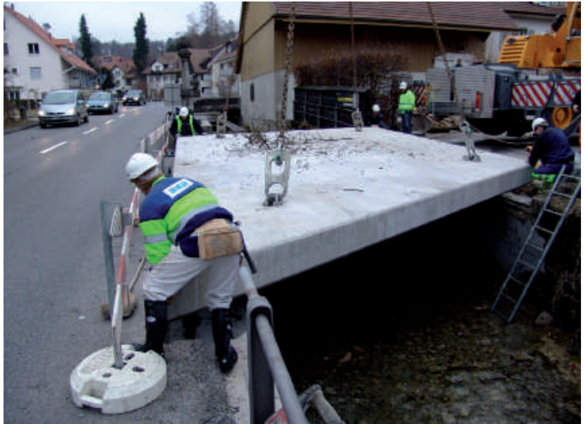
Millimetergenau senkt der Kran die schwere Platte auf ihre Lager ab. (ob)
