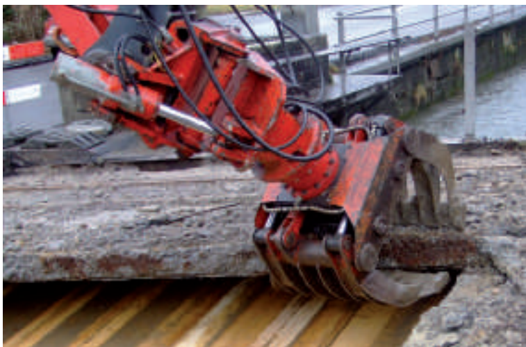
Abbruch der altersschwachen Brücke. (zvg)
